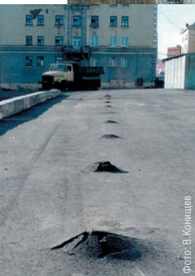
Рис.23-24 Примеры влияния таяния вечной мерзлоты на инфраструктуру: просадка фундаментов зданий (рис.23) и следы выпучивания свай (рис.24).
