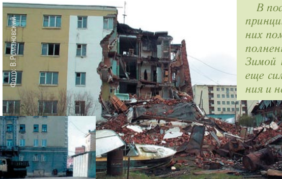
Рис.23-24 Примеры влияния таяния вечной мерзлоты на инфраструктуру: просадка фундаментов зданий (рис.23) и следы выпучивания свай (рис.24).
